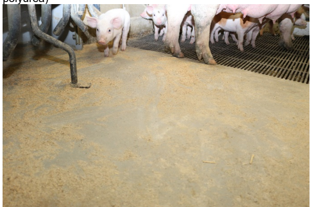
Gruppe 4: Overfladebehandling fra Nordic Total Byg (epoxy med glasperler)
